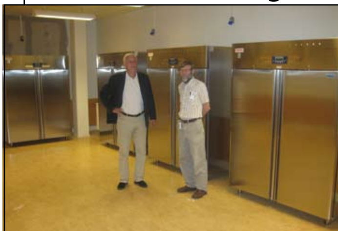
Vår säljare Anders Rothman tillsammans med Åke Ellin från Novum i rummet där de stora rostfria kylarna och frysarna installerades.
